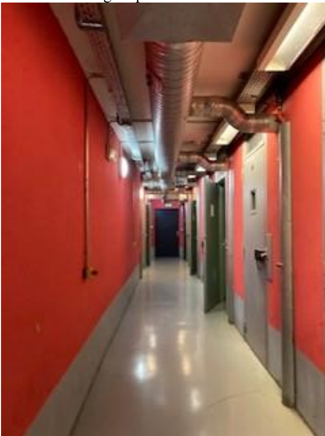
Couloir cellules de dégrisement
