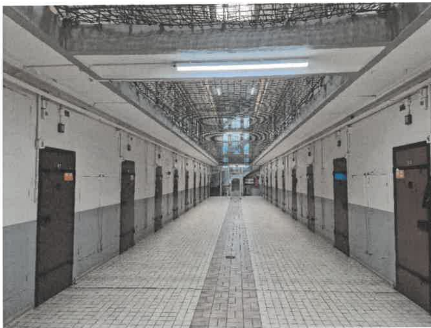
Vue du RDC
