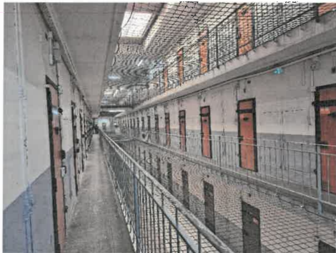
Vue du 1 er étage
