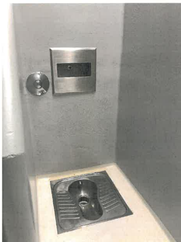
Toilettes de la cellule n°1
